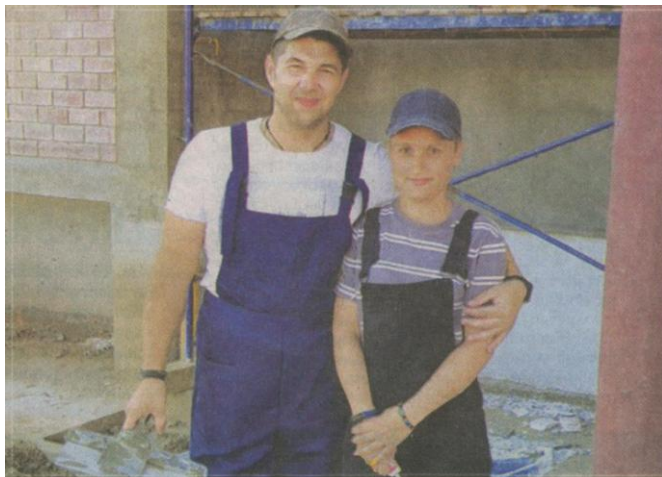
Руководитель бригады отделочников, штукатур Леонид Братов и штукатур Олеся Братова.
